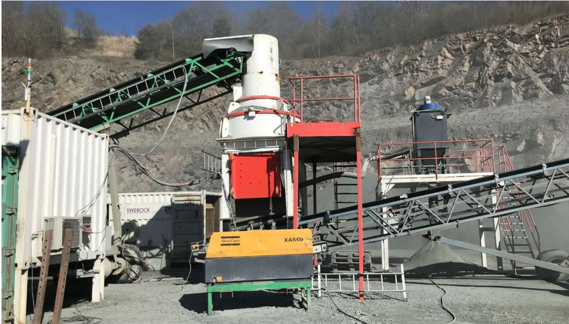
Figur 11. Barmac VSI hos Swerock i Källered.
